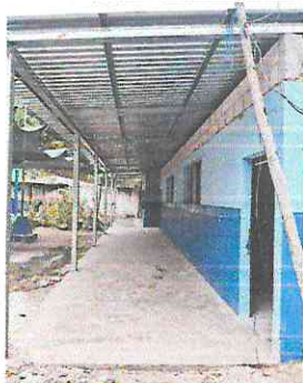
Foto 1: Proyecto finalizado de cambio de techo en aulas.
