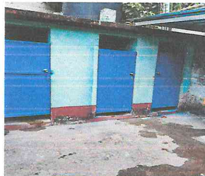
Foto 4: Proyecto finalizado de puertas de los baños.
