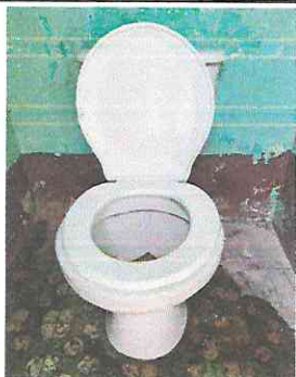
Foto 3: Proyecto finalizado de sustitución de sanitarios.
