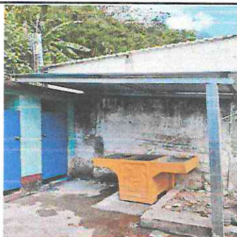
Foto 5: Proyecto finalizado de pila de concreto y galera con cubierta de lámina troquelada calibre 26.
